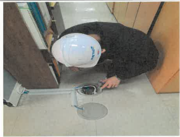
바닥 시스템박스(전기) 상태 육안점검
